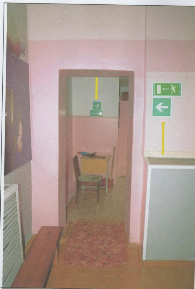
Фото №17 Указатели пути эвакуации.
