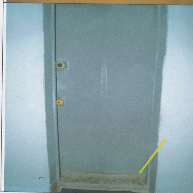
Фото №20 Эвакуационный выход недоступен для МГН, т.к. тамбур имеет порог 10см.
