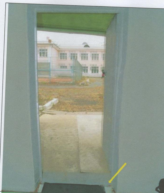
Фото №21 Эвакуационный выход недоступен для МГН, т.к. тамбур имеет порог 10см.
