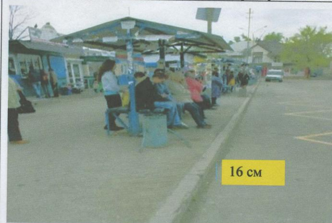
Фото №1 автобусная остановка №1. Высота бордюра 160 мм.
