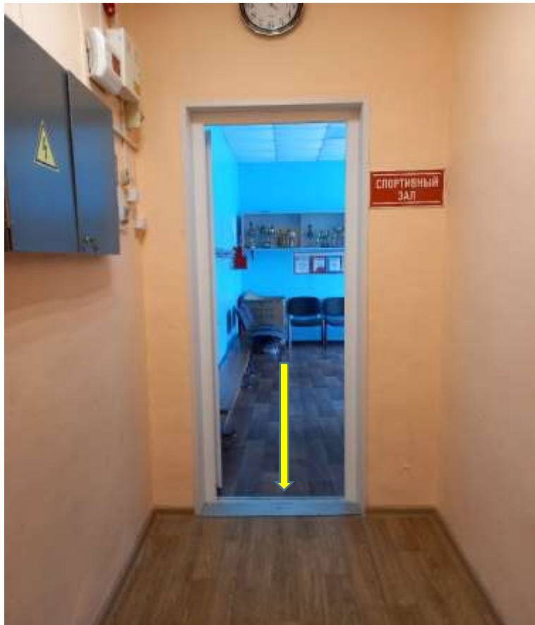
Фото №34 Пути движения внутри здания. Высота порога 7 см.
