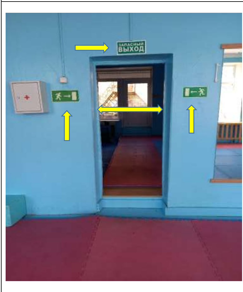
Фото №38 Пути движения внутри здания. Ширина двери 70см. Указатели путей эвакуации.
