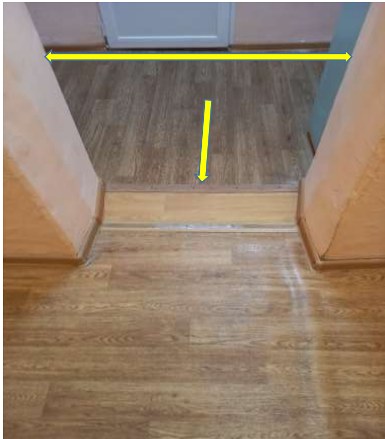
Фото №30 Пути движения внутри здания. Высота порога 5см. Ширина двери 70см
