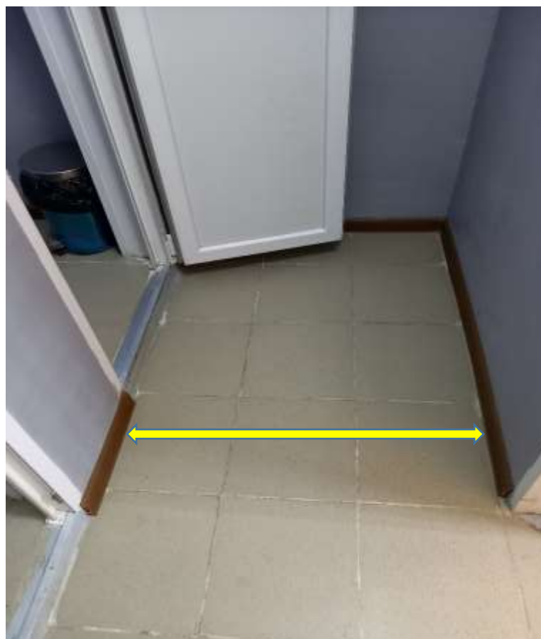
Фото №52 Санитарно-гигиенические помещения. Ширина коридора в санузле 90см.
