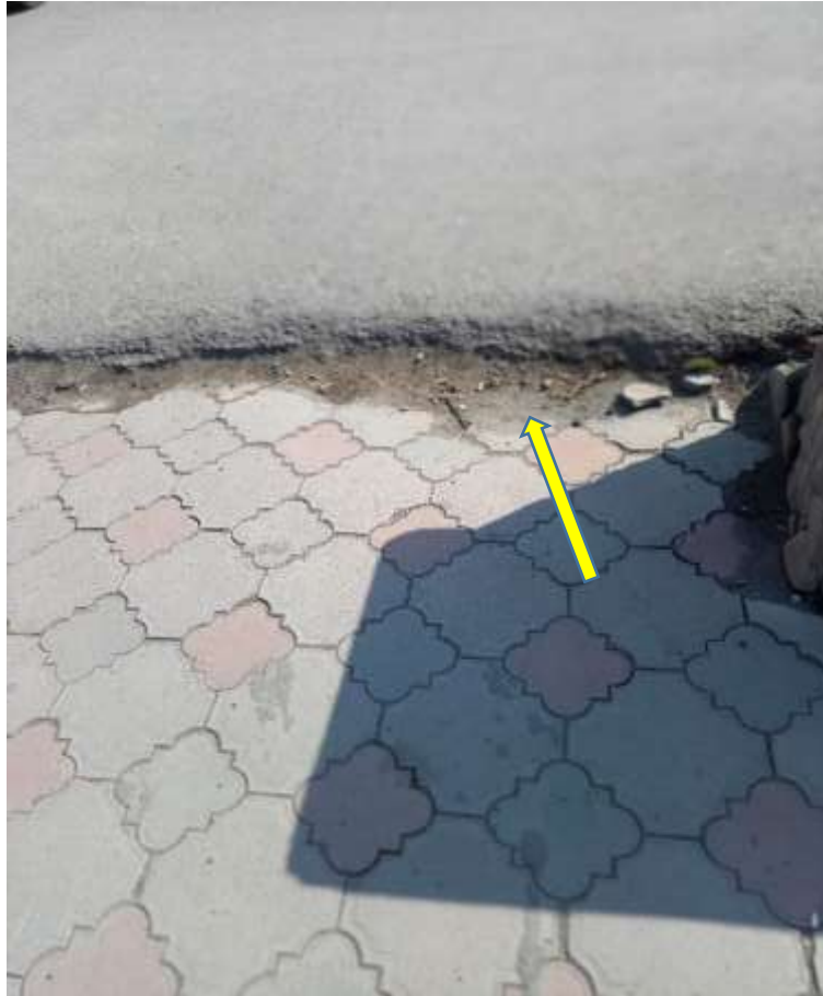
Фото №3 Путь к объекту. Высота асфальтового покрытия 10см.
