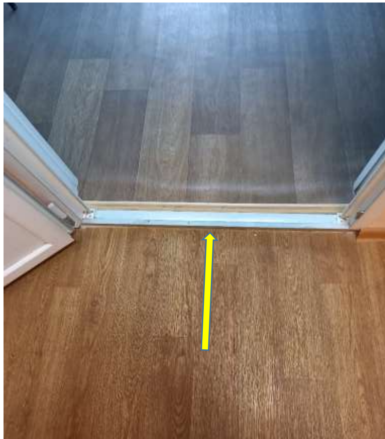
Фото №32 Пути движения внутри здания. Высота порога 5см.
