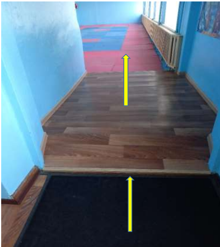
Фото №36 Пути движения внутри здания. Высота порога 16см.
