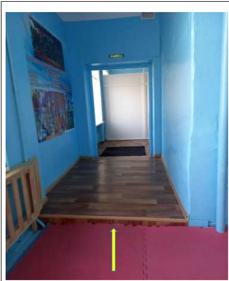
Фото №37 Пути движения внутри здания. Высота порога 8см.
