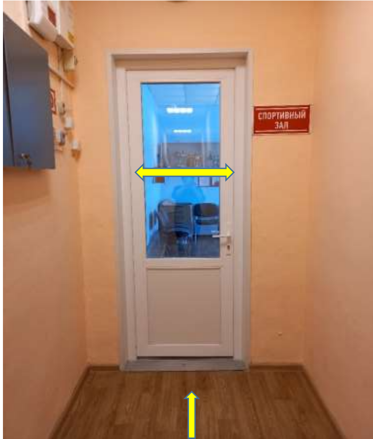
Фото №33 Пути движения внутри здания. Ширина двери 70см.
