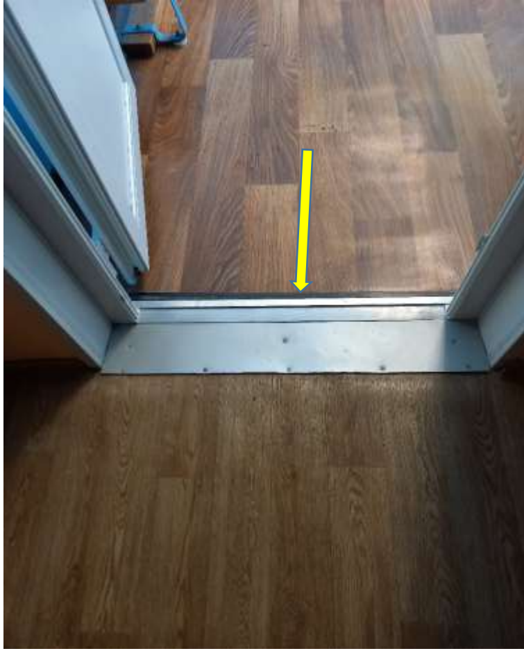
Фото №35 Пути движения внутри здания. Высота порога 7 см
