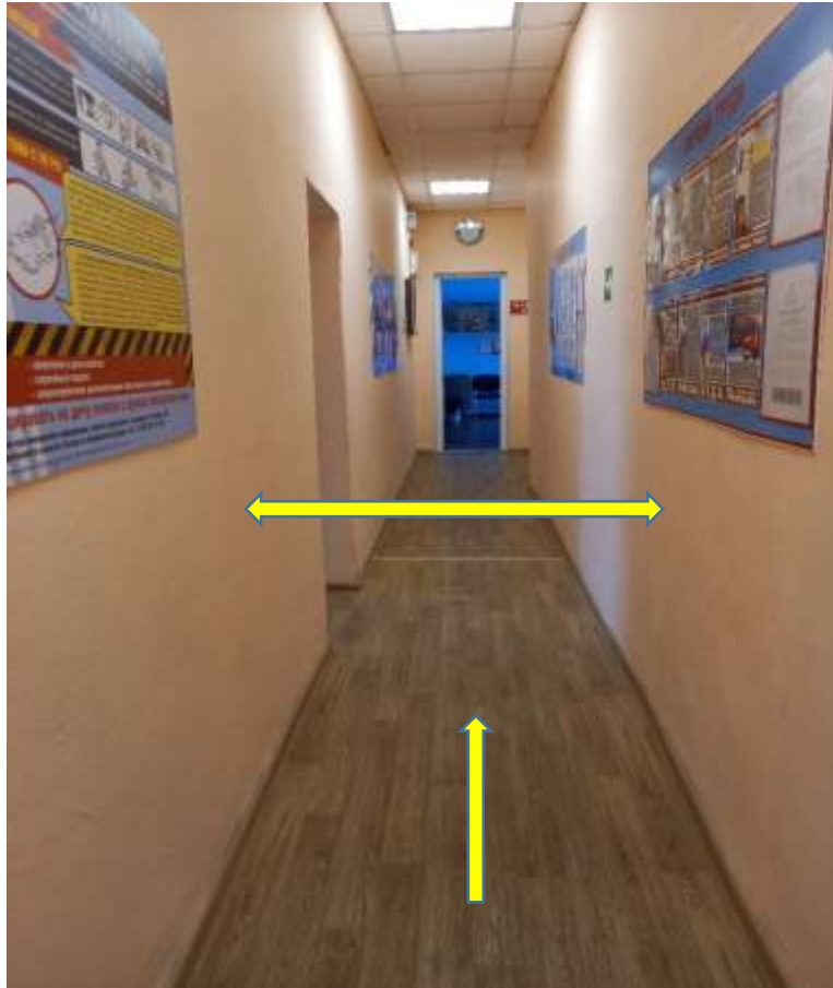
Фото №29 Пути движения внутри здания. Ширина коридора 110см.
