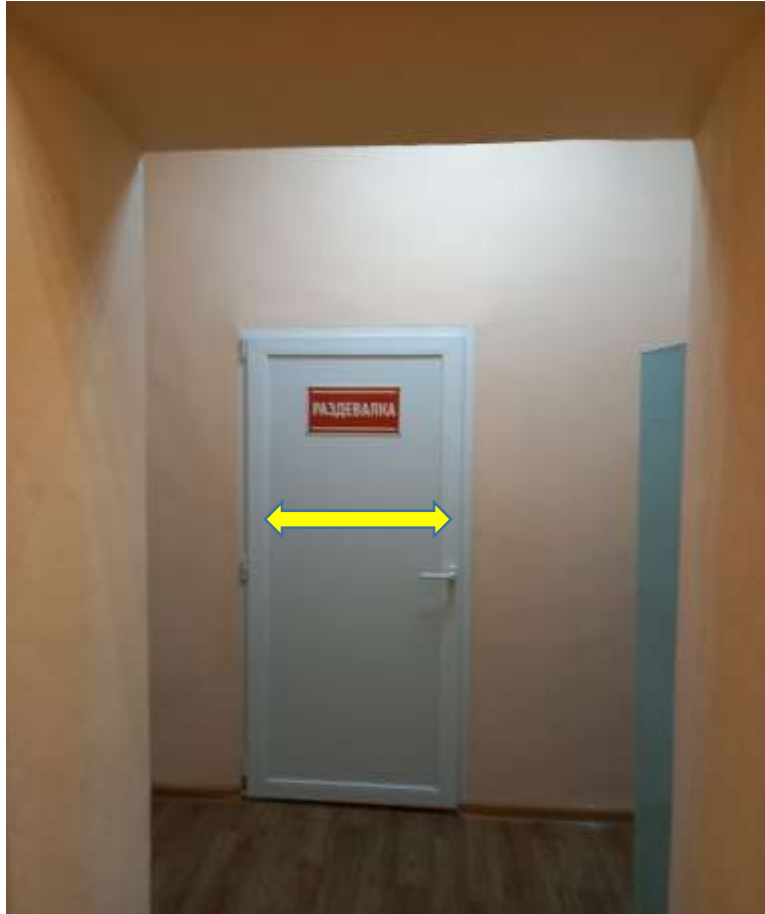
Фото №31 Пути движения внутри здания. Ширина двери 70см
